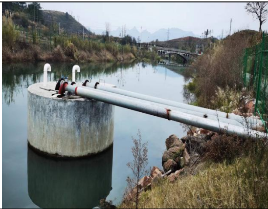
图 3 星子水厂取水点选址现状(位于现有取水点附近)
