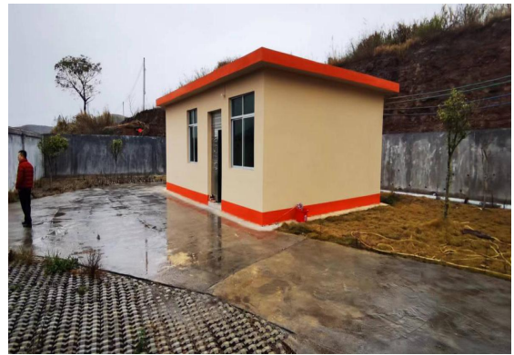
图 4 现有星子镇取水泵房现状(图片中为值班室, 可将值班室迁改后在此处建设泵站)
