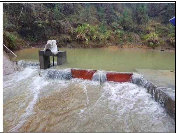
图 14 保安水厂取水源现状图
