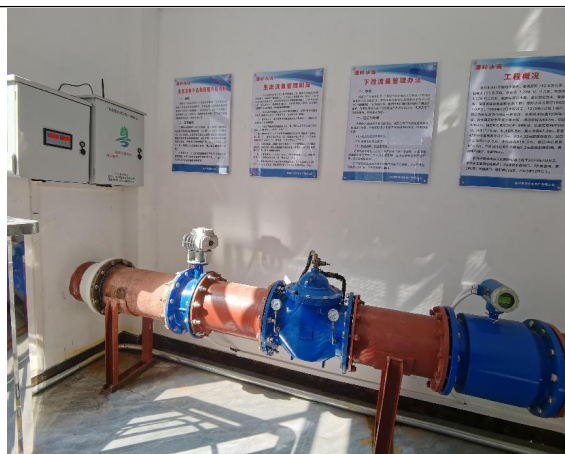
图片 10 生态流量管道及流量计
