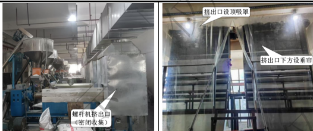
熔融挤出口设密闭集气罩收集废气 熔融挤出口设顶吸罩，下方设置垂帘
