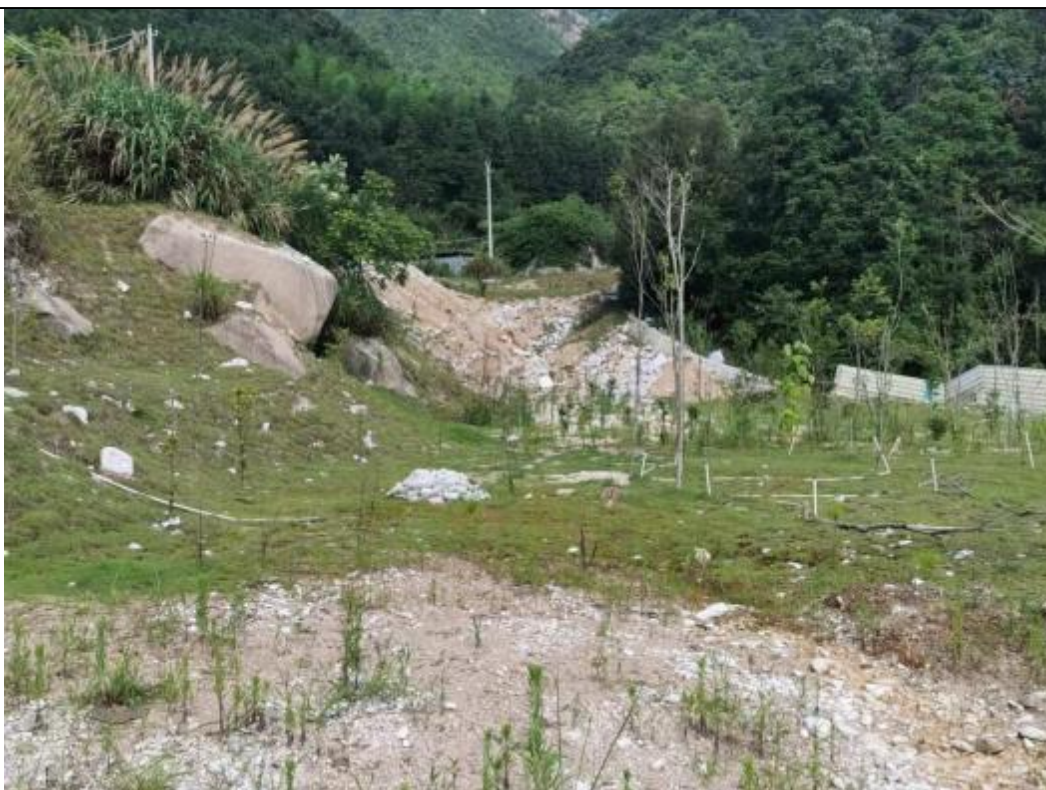
图 2-5 临时堆场现状图
