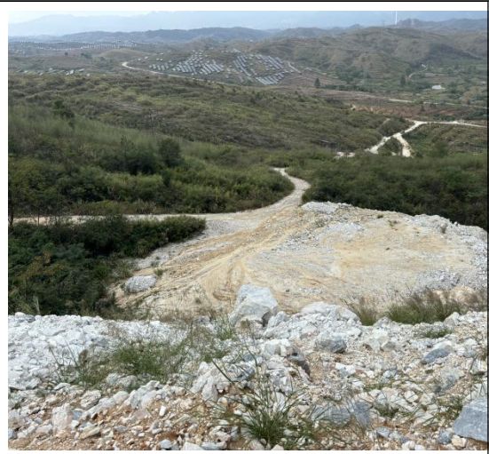
图 3-10 北侧排土场边坡现状 2
