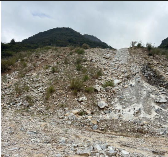
图 3-9 北侧排土场边坡现状 1
