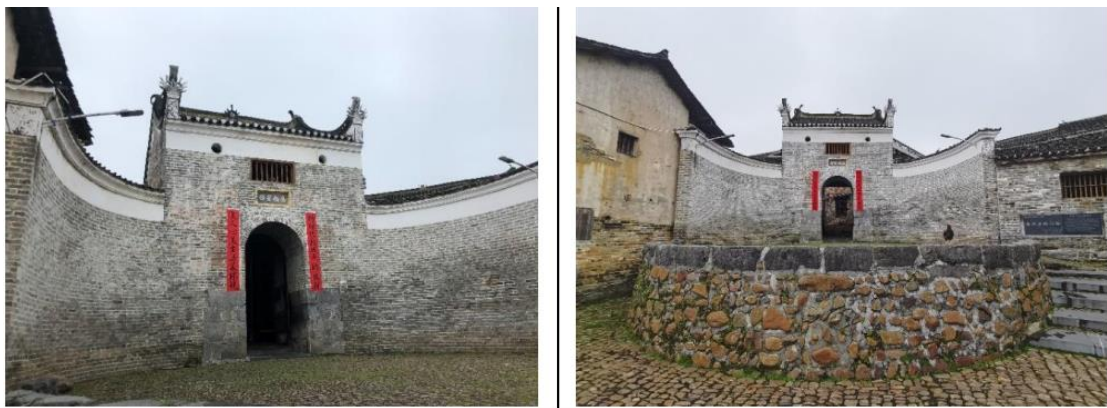
图 3.6 丰阳铺头街历史文化街区南极星辉门楼图
