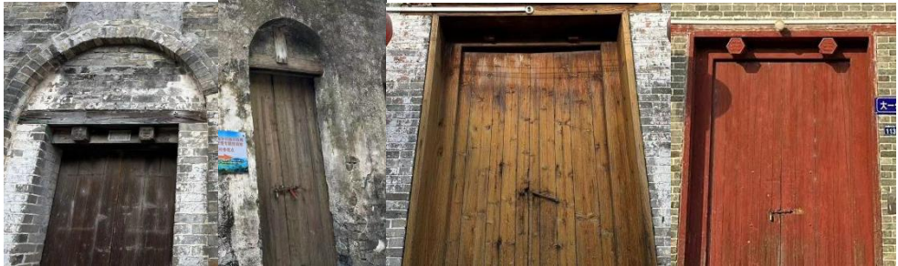
图 6.22 丰阳铺头街历史文化街区建筑门面样式
