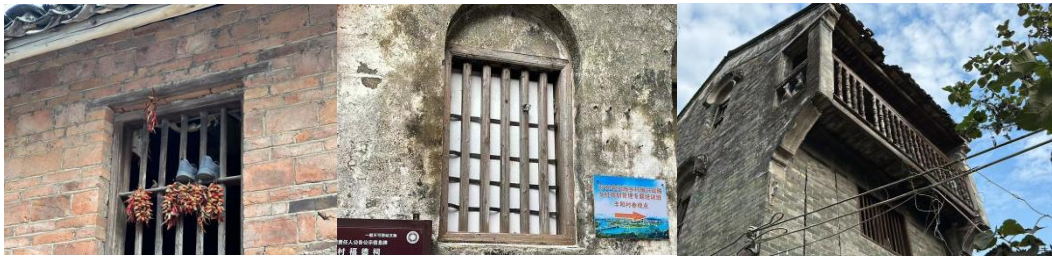
图 6.21 丰阳铺头街历史文化街区建筑窗户样式
