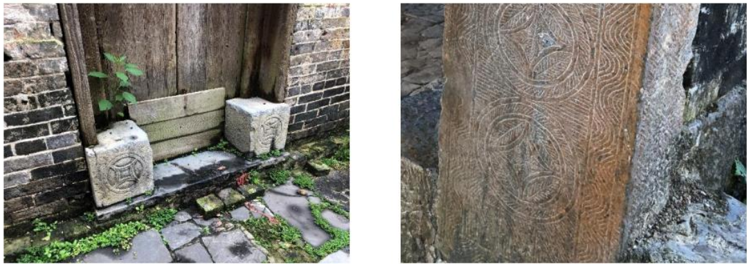
图 6.5 丰阳铺头街历史文化街区街巷铺装
