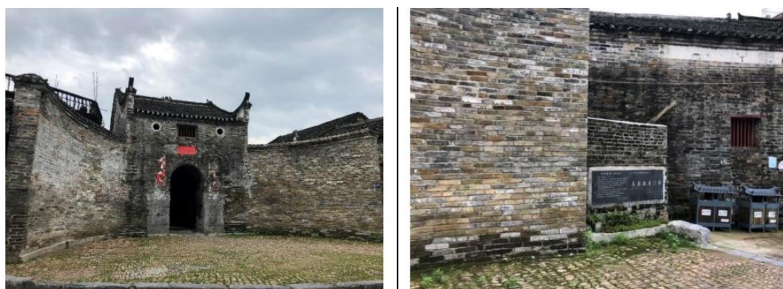
图 3.5 丰阳铺头街历史文化街区奎娄毓秀门楼图
