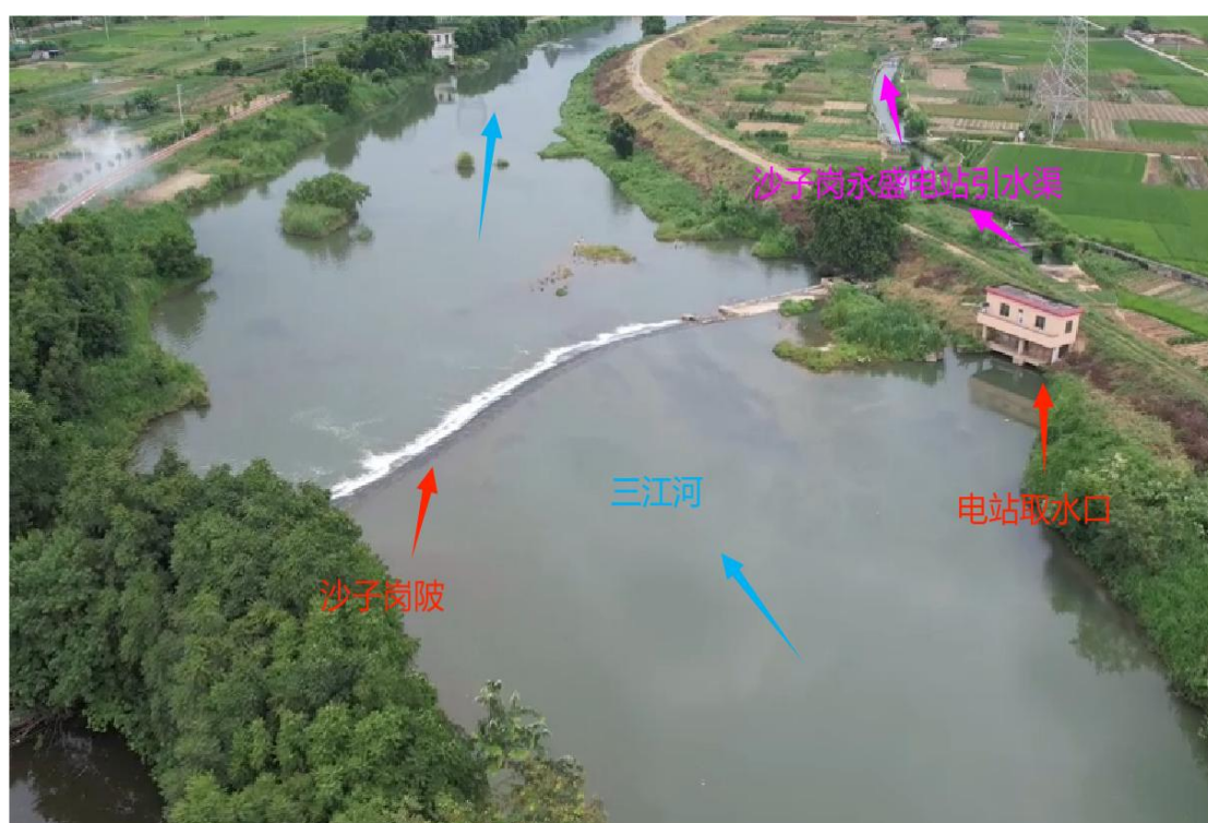
图 4.1.1-4 沙子岗陂现状
