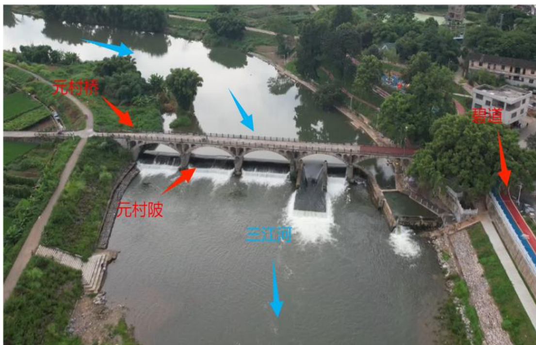
图 4.1.2-3 元村桥及元村陂现状
