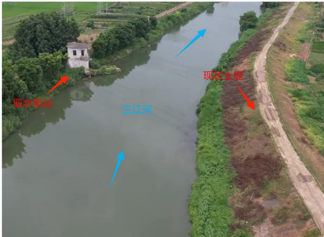
图 4.1.1-5 祥友混凝土公司抽水泵房（左岸）
